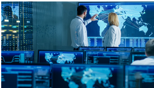
VIDEOWAND KONTROLLE & KVM
